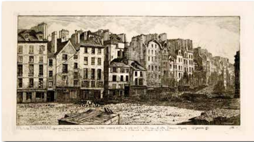
88/ RUE DE LA TIXERANDERIE (FACE MÉRIDIIONALE) APRÈS LA DÉMOLITION DE L'ÎLOT COMPRIS ENTRE LE CÔTÉ NORD DE CETTE RUE, ET CELLE FRANÇOIS-MIRON. 15 JANVIER 1851
